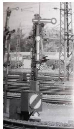
Sh1 an einem Signal der Bauform 1926 mit Blechkranz und Blech für Bezeichnungsschild
